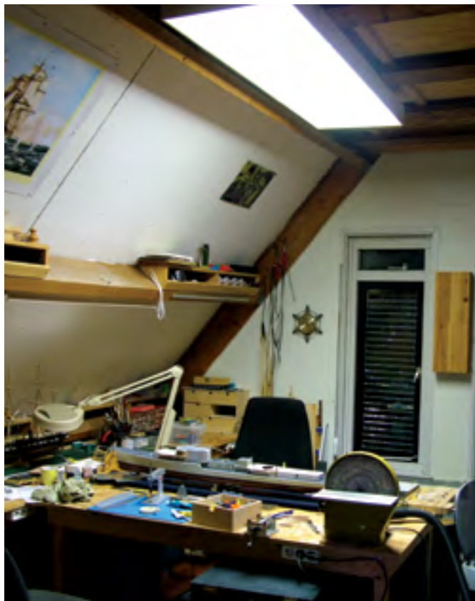
Verlichting in de hobbykamer; Een drietal tl-buizen met een verstrooiikap. Men ziet geen harde schaduwen op de werktafel.
