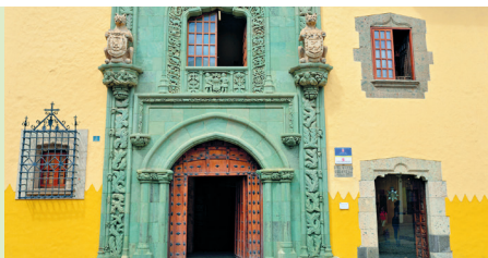
Het westportaal van het Casa de Colón met in steen gebeitelde beren, slangen, planten en Aztekenhoofden.
