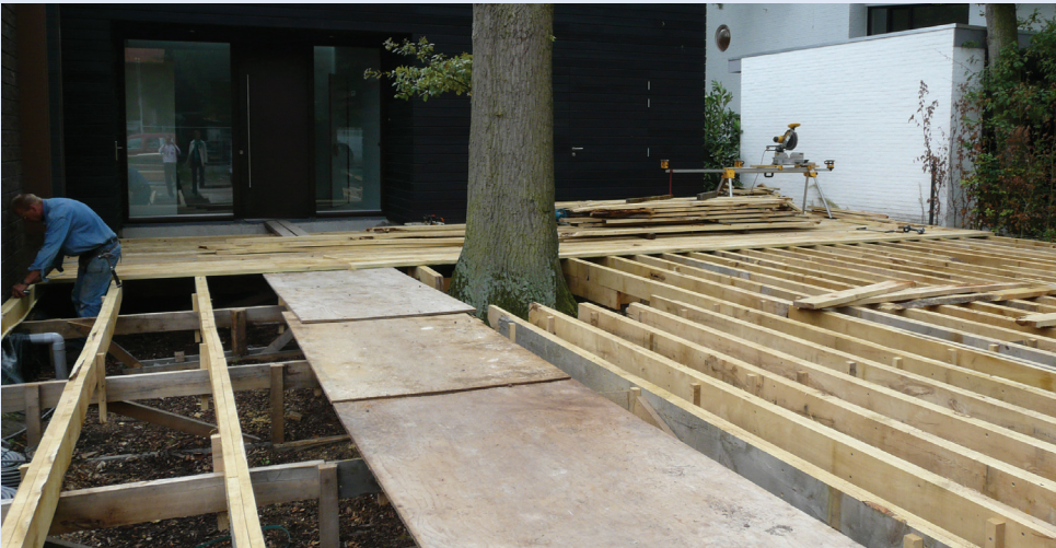
AFBEELDING 1.6 Houten dek rond boom
