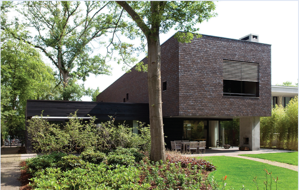
AFBEELDING 1.12 Het metselwerk van de gevel
